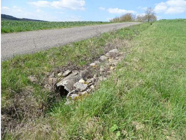
Abb. 4: Rohrdurchlass mit Steinen im Südwesten des Plangebiets
